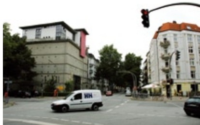
Der Heußweg beginnt an einem Ende mit einem Bunker und ...
